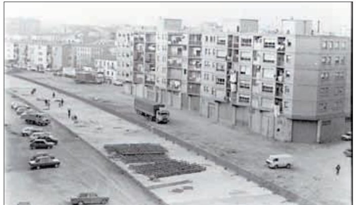
FOTO: R. Torralba Sans (Arxiu Municipal) / Obres del cobriment de la via de l'any 1983
